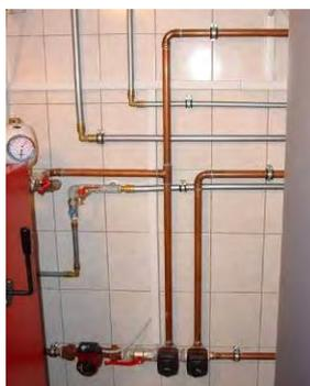
La ditta Dynergy S.r.l. consiglia i collegamenti idraulici di due motori. Con la seconda unità, consentiamo alla caldaia di pompare acqua più calda dalla parte superiore del serbatoio di calore. Rilasciamo la caldaia e permettiamo al sistema una maggiore quantità di energia. Il serbatoio è pieno solo di energia in eccesso.
