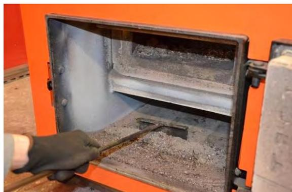
La camera di combustione non viene generalmente rimossa dal supporto. Eventuali incrinature sono tollerabili, la camera deve essere sostituita solo se il danno alla camera è progredito a tal punto che il normale funzionamento del dispositivo di riscaldamento viene interrotto, cosa che accade quando la forma della camera di combustione è significativamente cambiata o è stata demolita.
