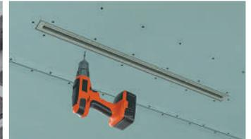
Il modello **SINGLE PROFILE** deve invece essere fissato direttamente ai profili in alluminio.
